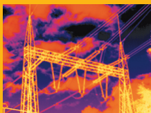
高圧送電線の点検
