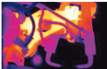
溶接ロボットのホットスポット
